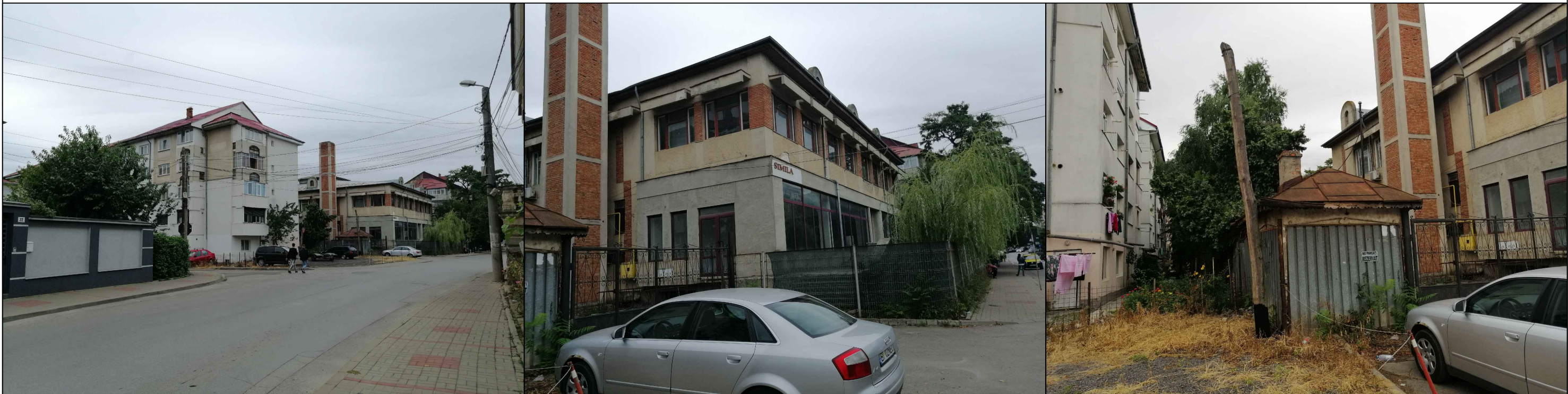
VEDERI CENTRALĂ TERMICĂ dinspre - Str. Victoriei
