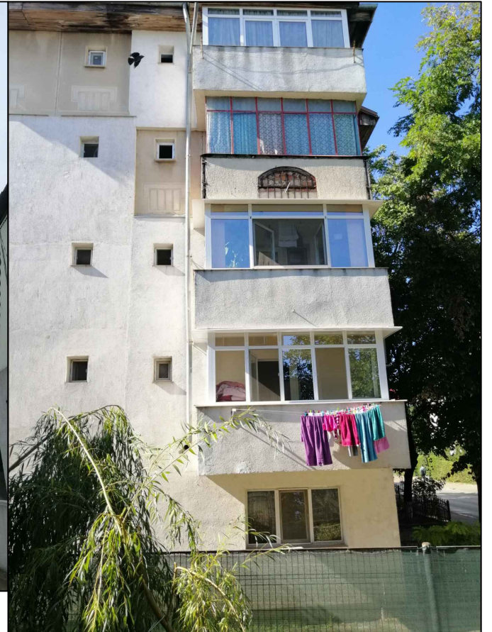
VEDERE FAȚADĂ LAT. ST. BLOC NR. 18, Str. Victoriei
