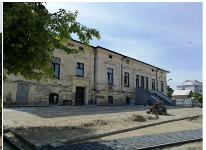
Vedere din strada Miorița.
