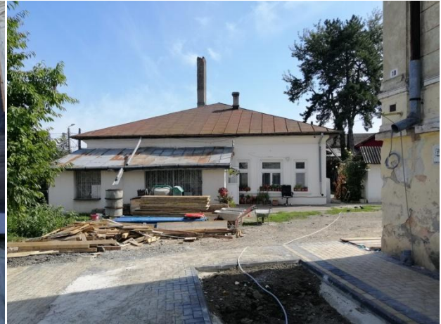
Vedere dinspre strada Miorița, din curte.
