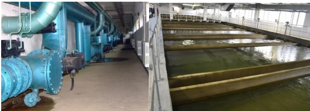
Foto: Infrastructura de tratare a apei potabile din municipiul Botoșani
