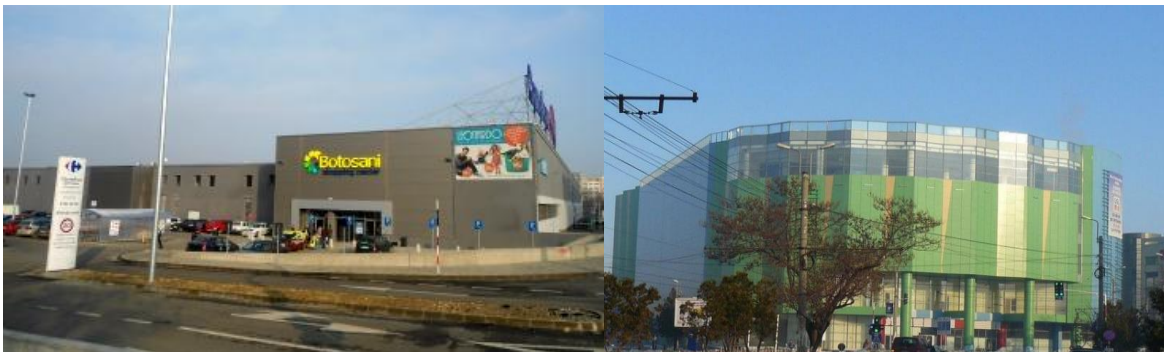
Foto: Centre comerciale construite recent în municipiul Botoșani (Botoșani Shopping Center – stânga / Uvertura Mall – dreapta)
