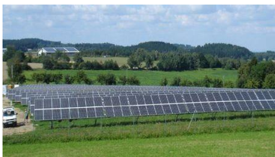
Foto: Parc fotovoltaic construit în apropierea municipiului Botoșani
