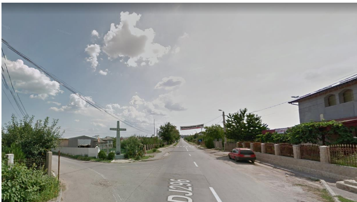
Figura 10. Intersecție – Strada Doboșari
