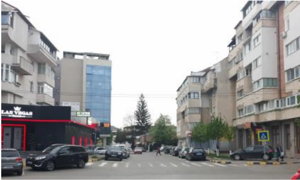
Figura 8. Trecere de pietoni - Strada Arhimandrit Marchian
